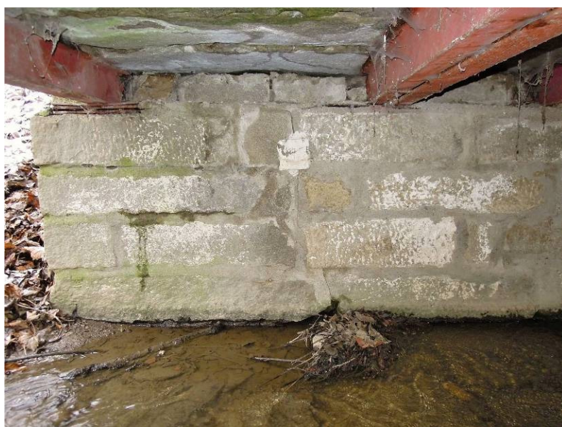
neporušený sádrový terč přes svislou trhlinu na levé straně opěry 2
