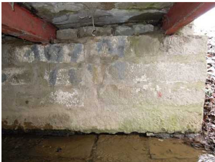
Opěra 1, levá strana, trhlina ve zdivu, částečně podemletý dřík, průsaky mezi kamennými bloky NK.
