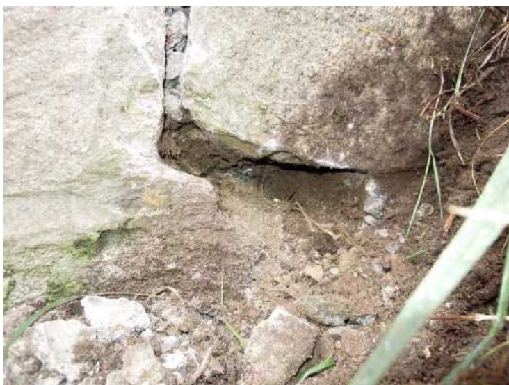
Detail rozpadu spárování zdiva na pravém boku OP2.
