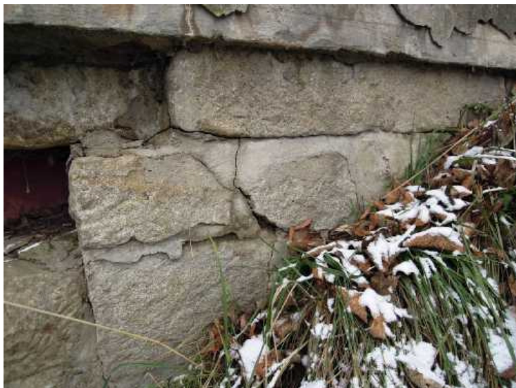
Opěra 2, pravá strana, popraskané spárování.
