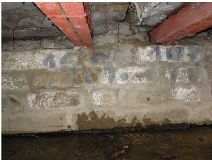
Opěra 1. Ve střední části narušená, mírně podemletá pata opěry.
