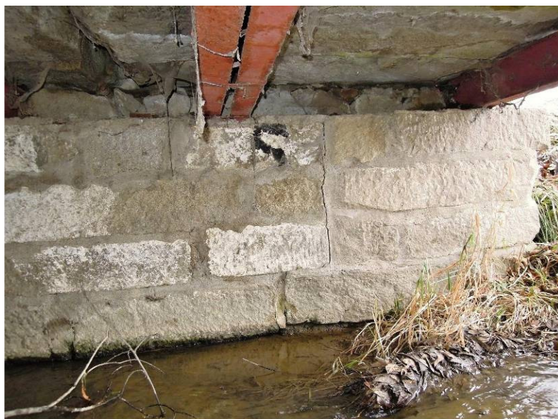
pravá strana líce opěry 2, svislá trhlina oddělující krajní část, začínající podemílání paty
