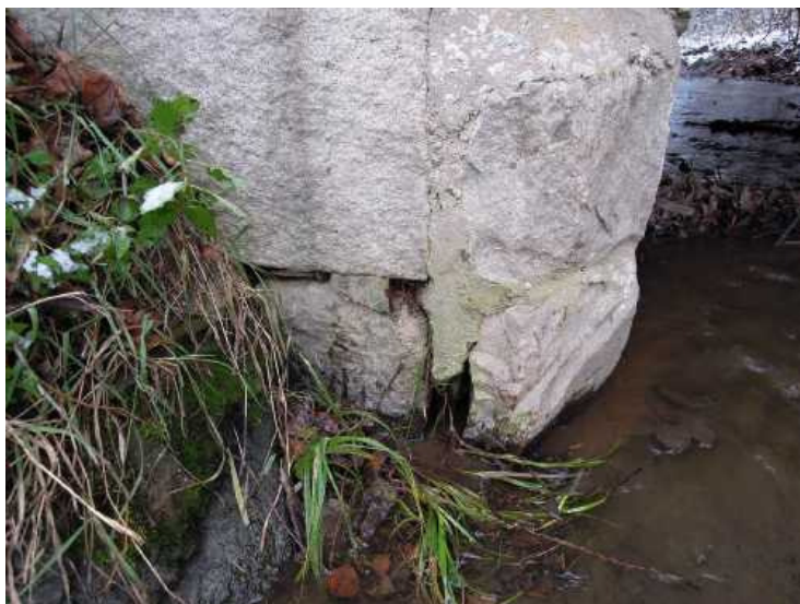
Opěra 1, pravý bok - provizorně nedostatečně doplněné spárování.
