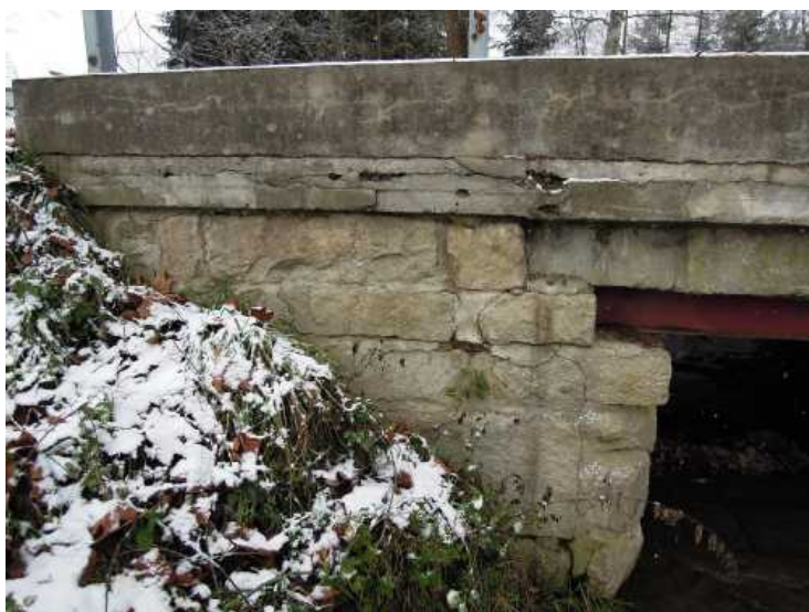
Opěra 1, pravá strana. Trhliny ve sparách zdiva. Rozpad betonu původní římsy.
