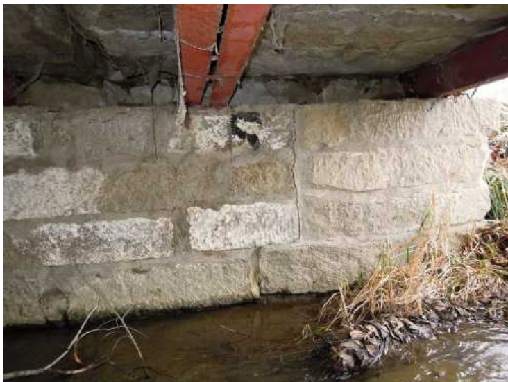
Opěra 2, pravá strana, vertikální trhlina ve zdivu opěry vně zdvojeného nosníku.
