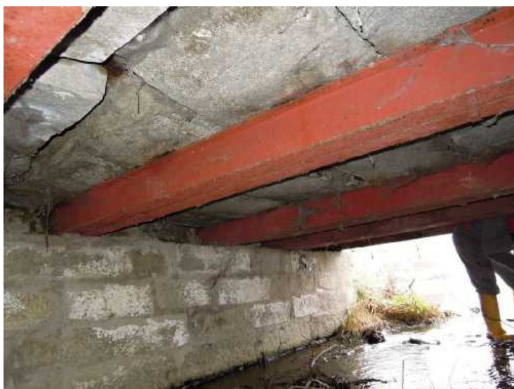
Opěra 2. Podhled NK - styk konzol kamenných bloků mezi nosníky, povrchová koroze ocel. nosníků.
