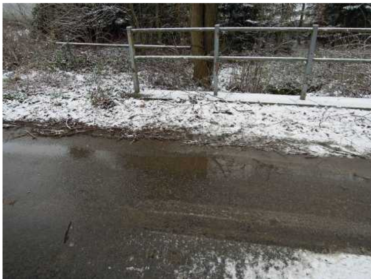
Levá strana nad OP1, bezodtokové místo na vozovce, nánosy nečistot na krajnici.
