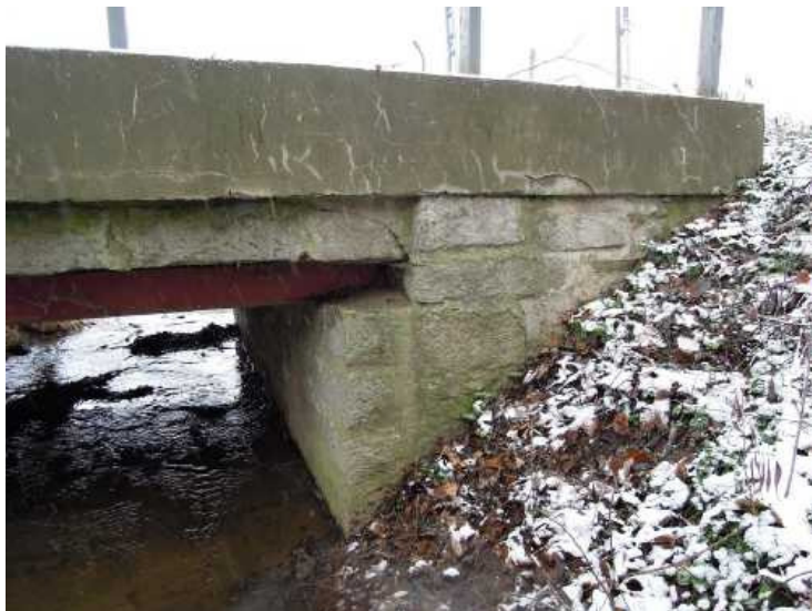
Opěra 1, levá strana, poruchy v omítce římse.
