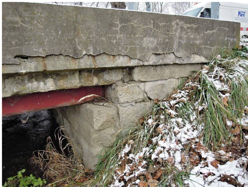
popraskané spárování na pravém boku a křídle opěry 2, po odstranění "nové" malty zastižena původní rozpadlá
