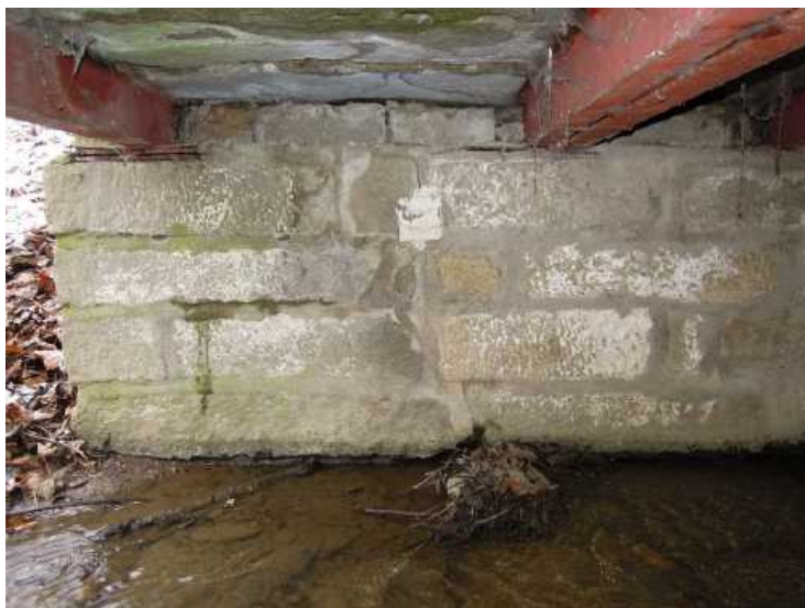
Opěra 2, levá strana, osazený sádrový terč přes trhlinu ve zdivu opěry - neporušený.
